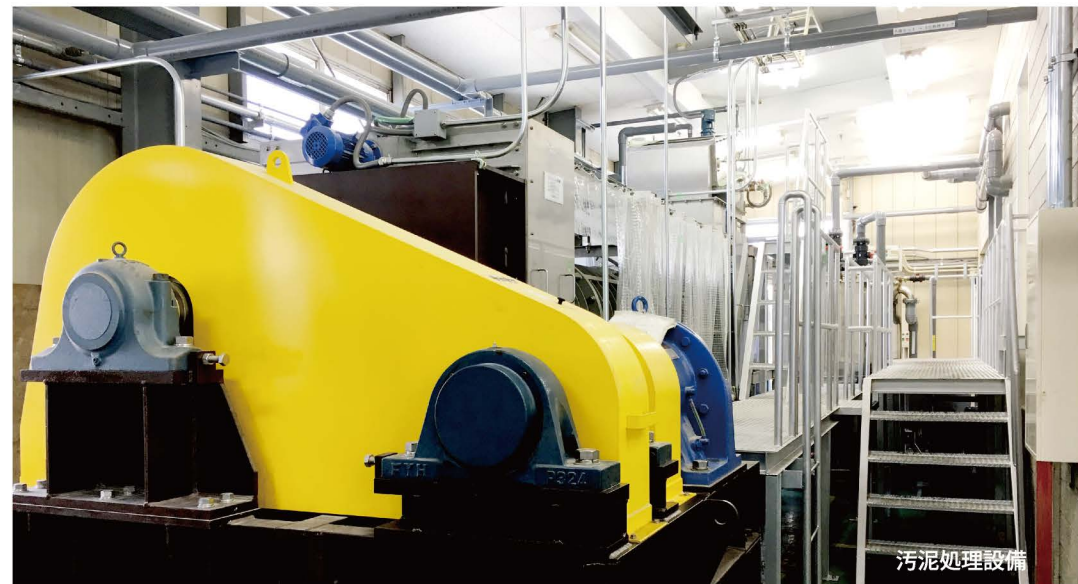
スクリーンプレス脱水機
